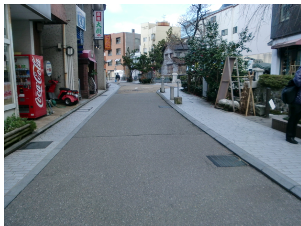
写真-1 金沢市内の狭い道路網の例（金沢市 南町界隈）
