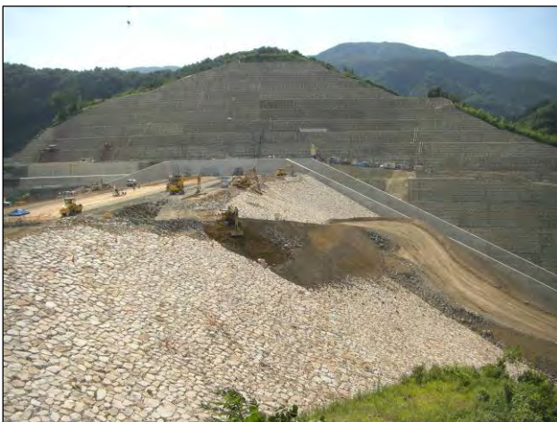
写真-1 盛立工施工状況
