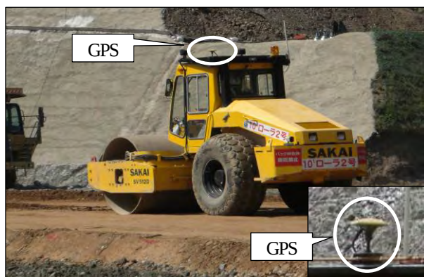
写真-5 締固め作業状況（コア）
