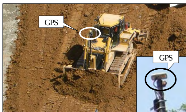
写真-3 まき出し作業状況（コア）
