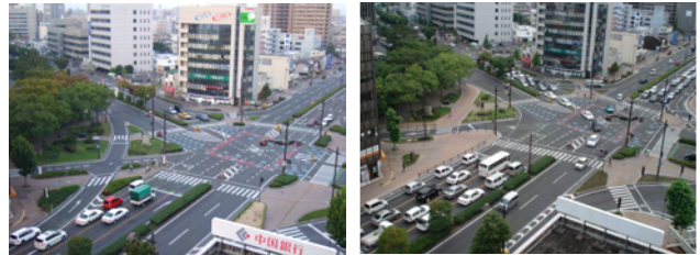
図-6 左折導流路の撤去（事前・事後）
