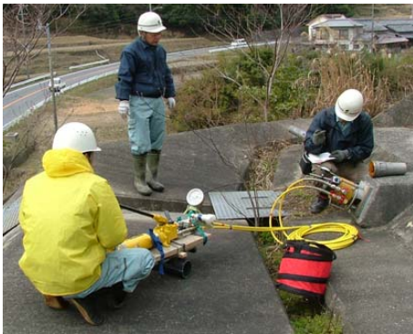
図-1 SAAM ジャッキによる面的調査状況
