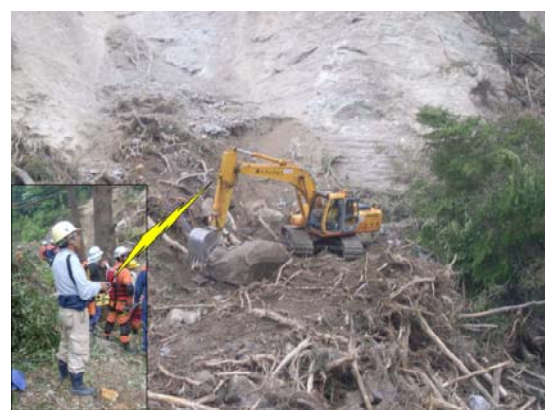
図－１０ 無人化施工イメージ
