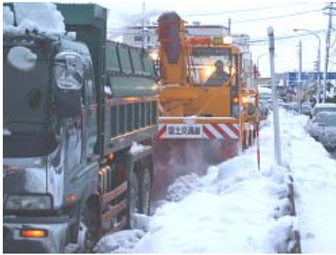
写真-1 運搬排雪実施状況 (国道7号 栗ノ木バイパス)
