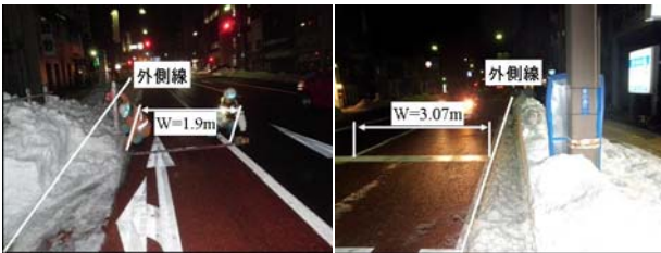
写真-2 雪堤による幅員阻害 写真-3 幅員確保状況 (国道116号 東中通)
