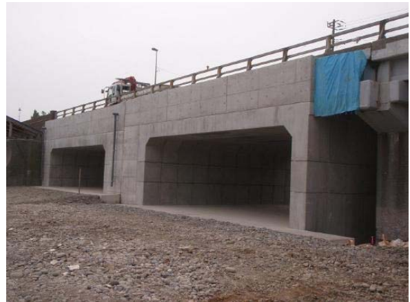
写真-14 完成写真
