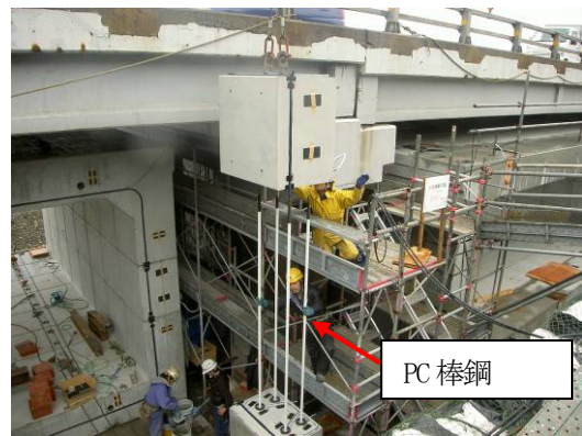
写真-8 ボックス組み立て(中ピース)
