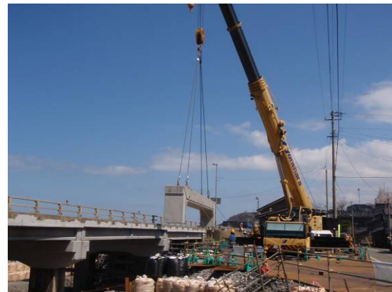
写真-9 ボックス組み立て(上ピース)
