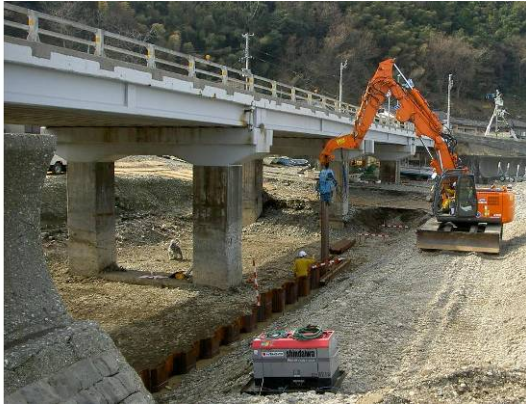
写真-6 止水矢板打設
