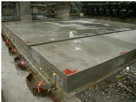
写真-7 底板コンクリート
