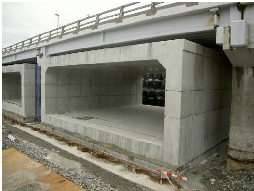
写真-11 ボックスカルバート引込完了
