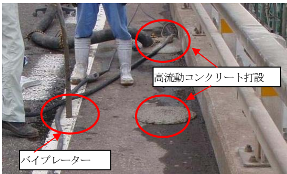
写真-13 ボックス上部高流動コンクリート打設
