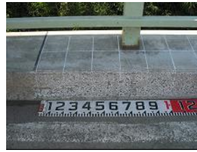
写真-9 塗布5年後の地覆のスケーリング状況
