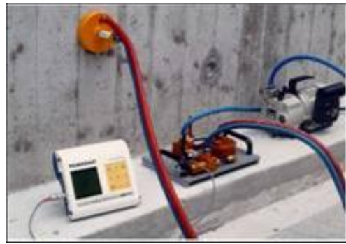
写真-4 表面透気試験状況 (TORRENT法)
