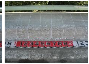
写真-9 塗布5年後の地覆のスケーリング状況
