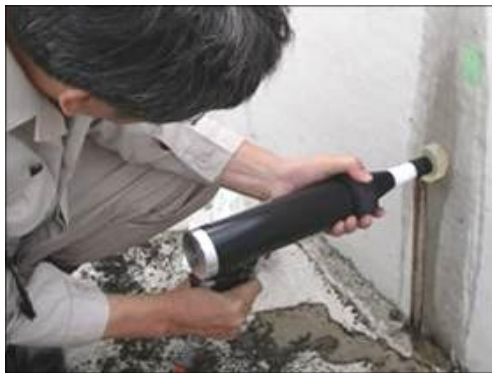
写真-1 ひび割れ閉塞工法
