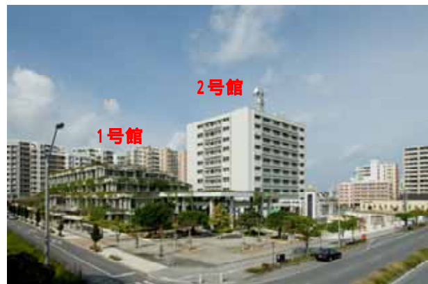
写真-1 N庁舎 外観写真
