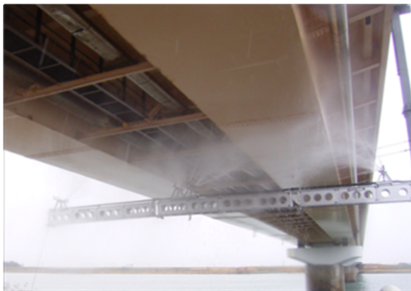
図-7 橋梁洗浄の状況
