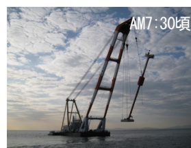
写真-8 新規灯標運搬
