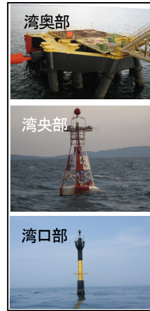
写真-3 設置現地
