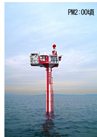
写真-10 新規灯標設置後
