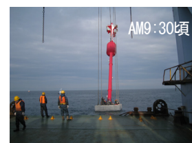
写真-9 新規灯標据付
