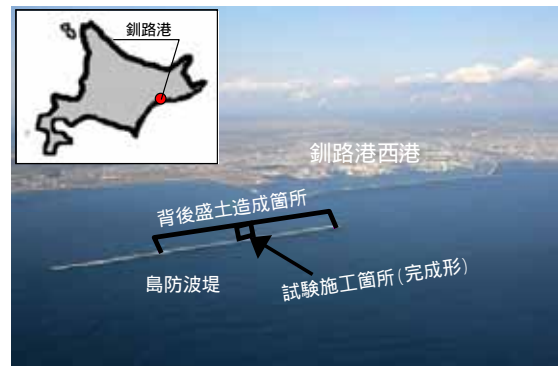
写真-1 釧路港西港区整備状況
