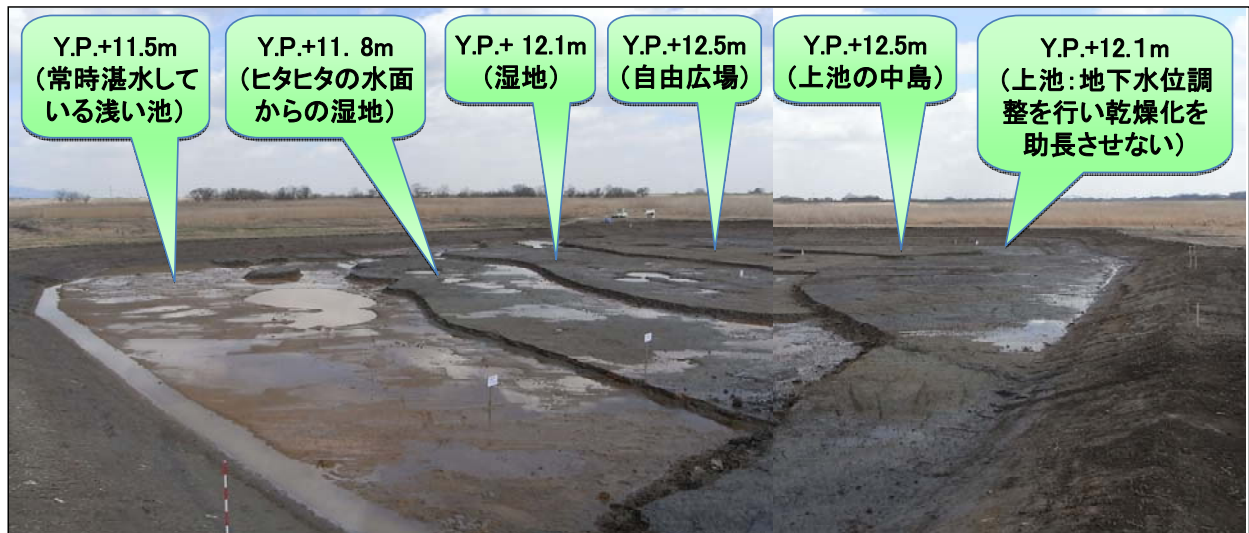
写真-3 環境学習フィールド掘削状況（掘削直後）
