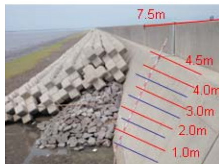
図-18 直立堤でのうちあげ高計測
