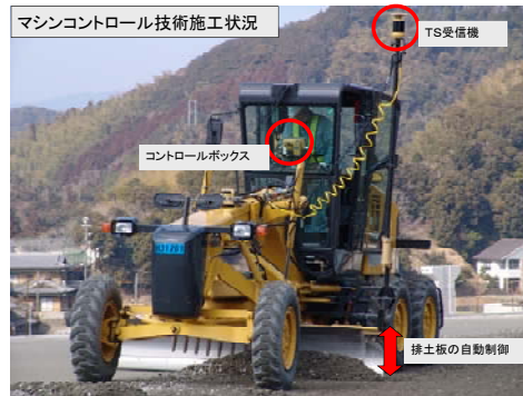
写真-5-1-1 MCモータグレーダの施工状況
