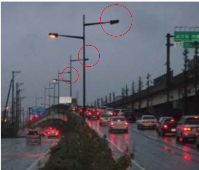
高架橋の消灯実験の状況
