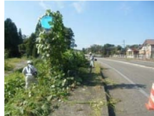
<除草作業の状況>
