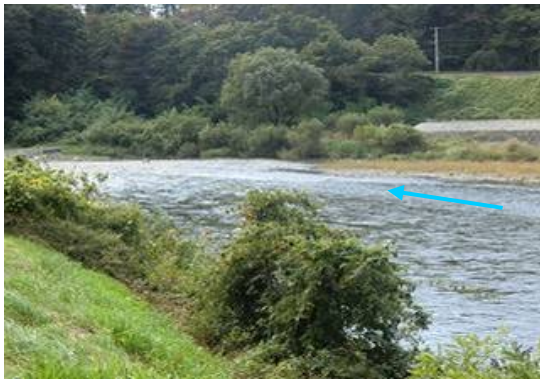
写真-7 山付部の状況(辰野町209.4kp付近)
