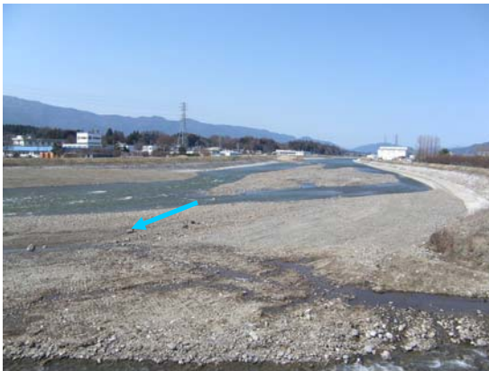
写真-5,6 出水後(上)と施工後(下)の河床状況 (伊那市197.4kp付近)
