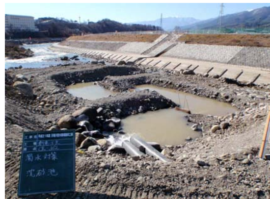
写真-13 沈殿池設置状況
