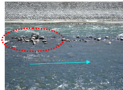
写真-11 大石の配置状況 (伊那市193.4kp付近)
