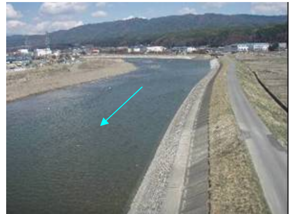
写真-8,9 施工前(上)と施工後(下)の状況 (伊那市197.2kp付近)
