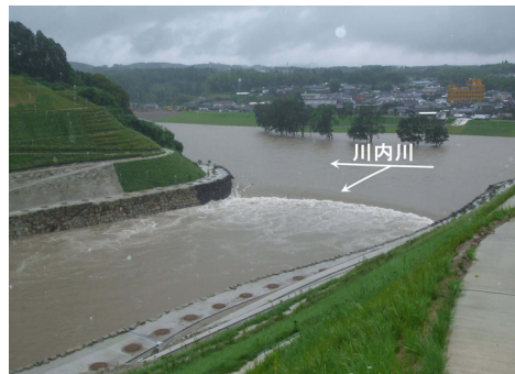
写真-7 推込分水路分派状況
