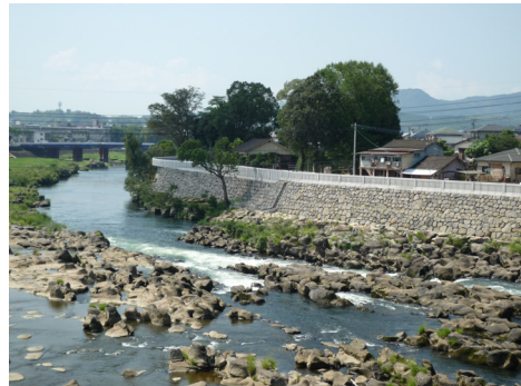
写真-6 虎居地区完成写真
