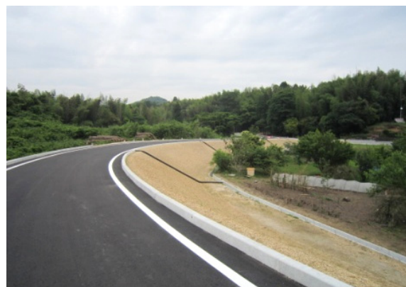
写真-6 輪中堤完成写真
