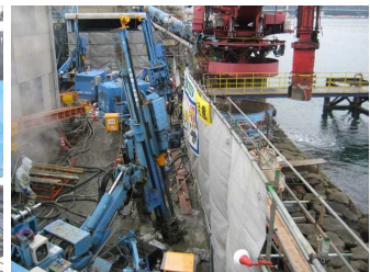
写真-5 施工状況 (全景)
