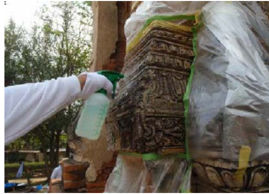
写真-7 漆喰レリーフの劣化防止処理
