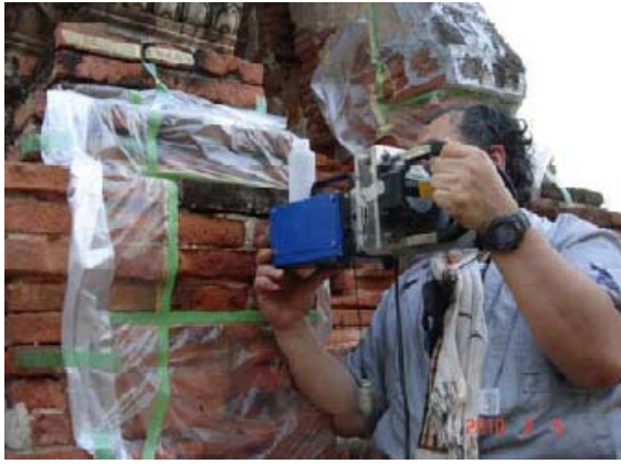
写真-6 削孔試験装置機による表層強度の測定
