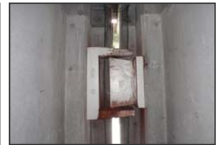
写真3-3 中央ヒンジ部 ゲレンク沓の状況
