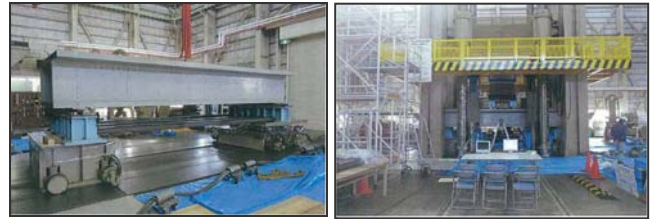
写真6-1 試験体設置状況
