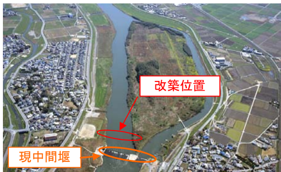
写真-1 中間堰付近の航空写真
