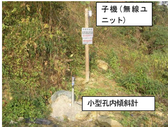
図-8 小型孔内傾斜計の設置状況
