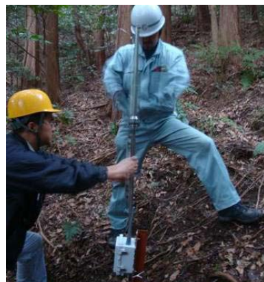
図-4 機器の設置作業
