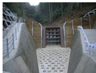
図-2 障子ヶ谷堰堤
