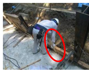
図-13 バタ板設置状況
