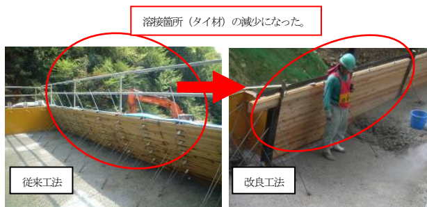
図-9 従来工法との比較写真 (タイ材比較)
