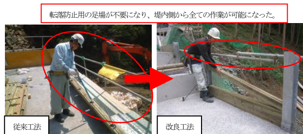
図-10 従来工法との比較写真 (間伐材設置施工時)
