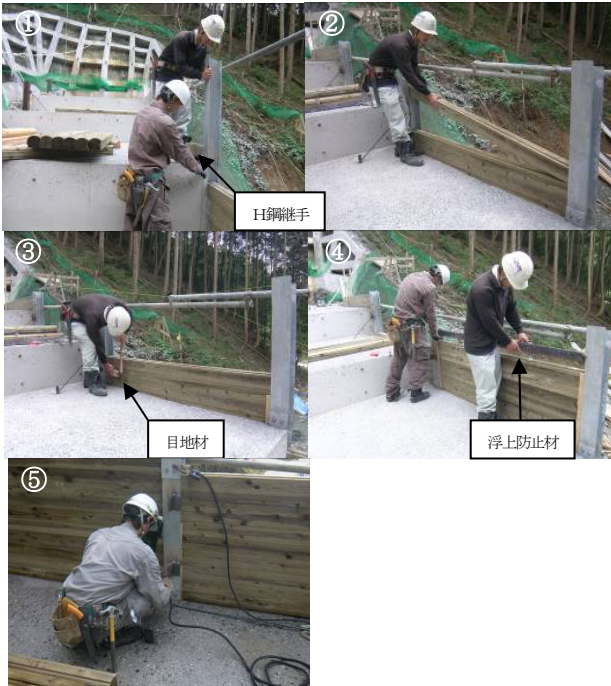
図-7 改良工法施工状況写真
