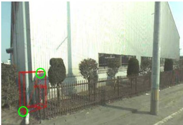
図-3 MMSで取得された画像上における浸水痕の高さ計測
