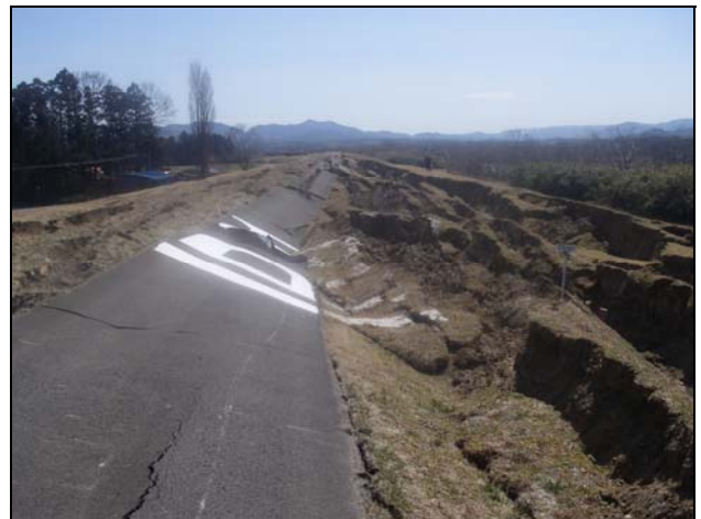
図-14 被災した対空標示（R31）
