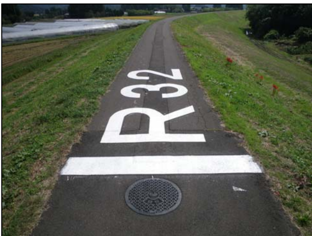
図-7 R 3 2 施工完了
