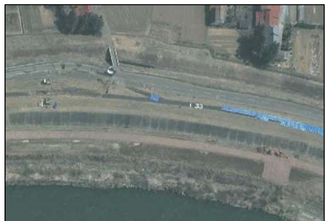
図-15 災害復旧箇所と対空標示（R33）
