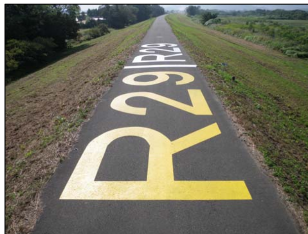
図-4 R29施工完了
