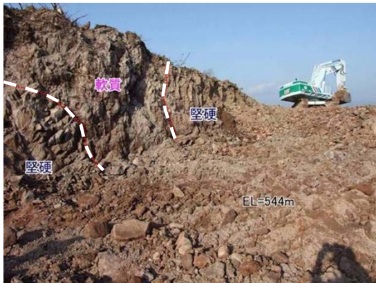
図-4 An5層上端付近の掘削状況
