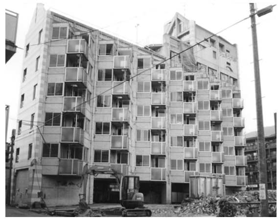
(a) 建物全体（構造はRC造剛節架構）
