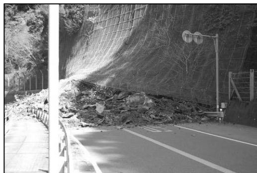
写真-7 法面崩壊写真
