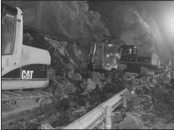
写真-8 土砂撤去状況写真
