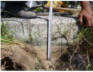
(a) 路盤材までの深さ確認
