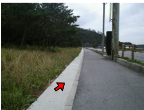
(a) 張りコンクリート施工例
