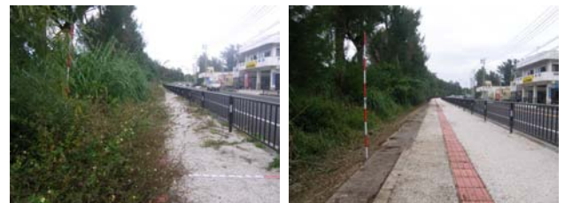
(a) 除草前 (b) 除草後 写真-3 点字ブロックの除草事例
