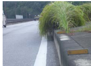
(b) 張りコンクリート
