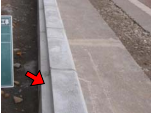
写真-10 切り欠きを設けた改良縁石
