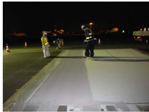
図-9 空港での施工状況
