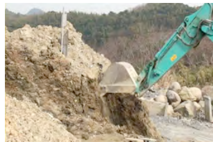
(b) P8を掘削する様子
