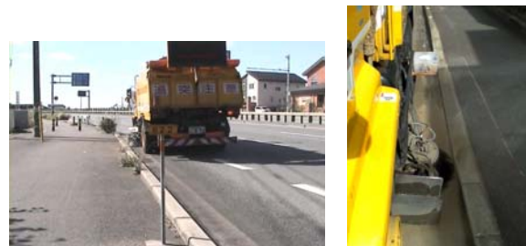
写真-2 粉塵発生状況 (ブラシ経由給水方式)
