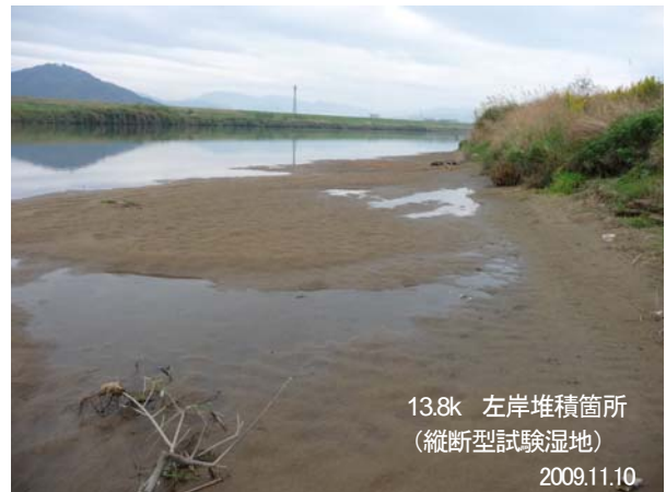
図-10 湿地整備箇所の状況 (整備後4年)
