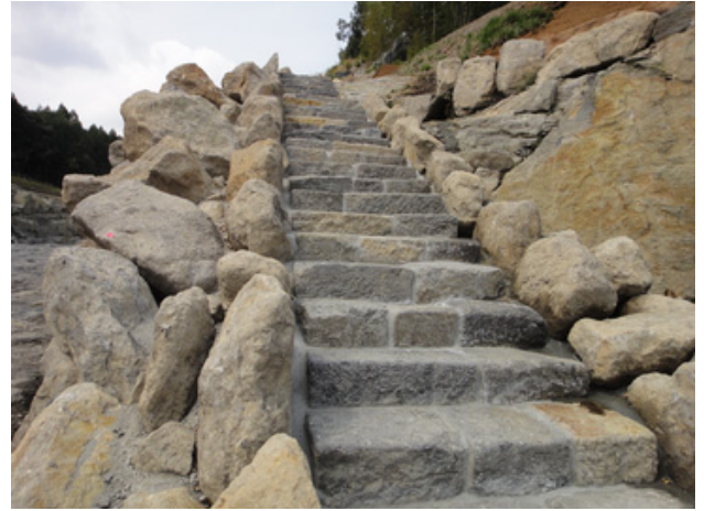
写真-3 転落防止の工夫
