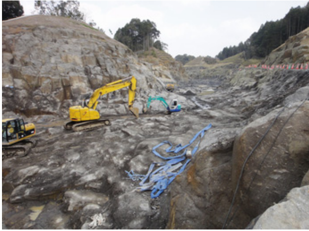
写真-2 河床仕上げの様子
