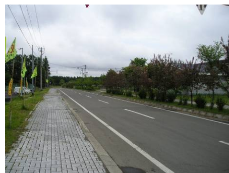
写真-3 歩道にブロック舗装をした郊外道路(北海道)
