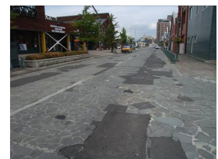
写真-12 自然石舗装のアスファルト補修(北海道)
