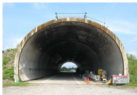
図-6 模擬トンネルの外観
