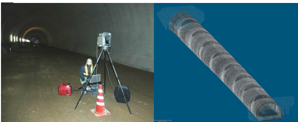
図-11 定置式3Dスキャナによる計測状況と計測データ (右)
