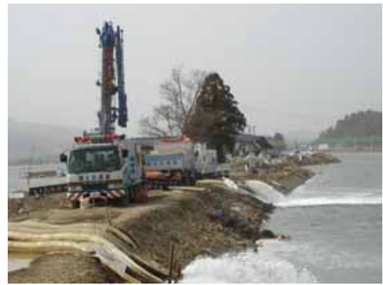
図-10 北上川下流（月浜第一樋門付近）排水状況
