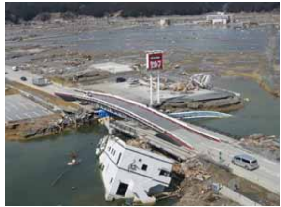
図-15 架設した応急組立橋（全景）
