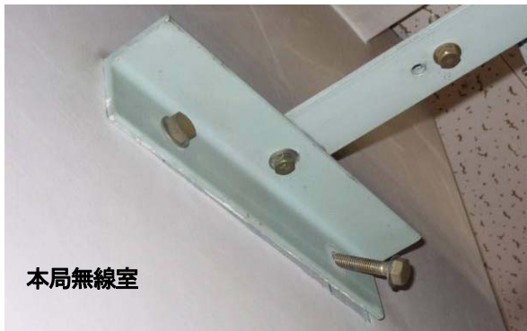
写真-10 ストラクチャーボルト状況 (抜け)
