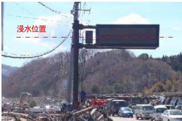
写真-6 道路情報板浸水状況 (岩手県宮古市)
