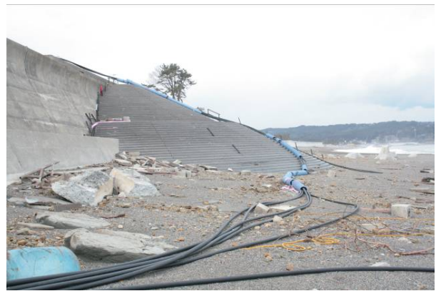
写真-13 情報BOX法面埋設部 (岩手県野田村)
