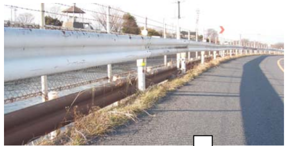
整備後：管理用通路の設置
