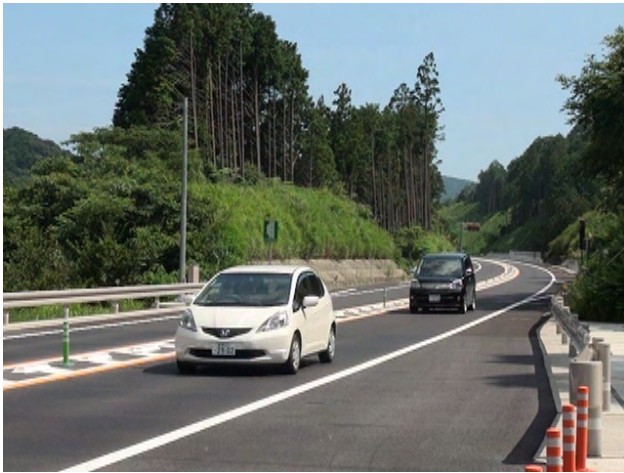
図-7 開通後の三遠南信自動車道
