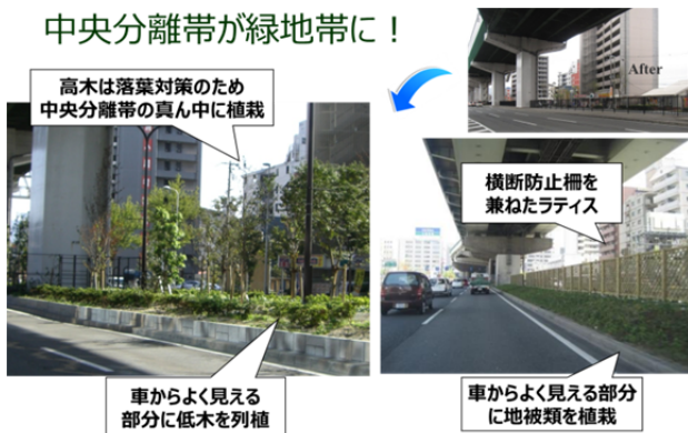
図-7 国道 308 号高架下緑化
