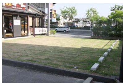
写真-5 緑化駐車場の無償施工
