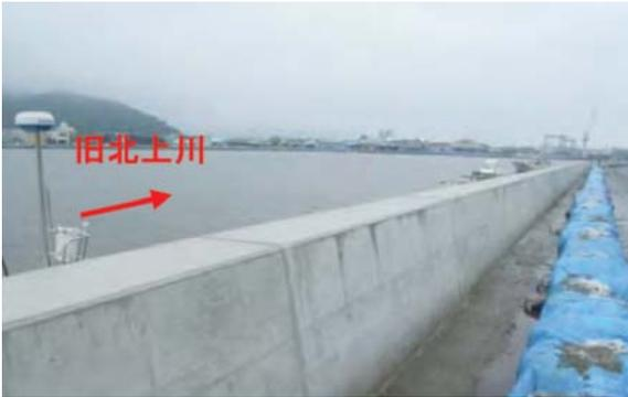
写真 5 既設コンクリート堤の嵩上げ後
