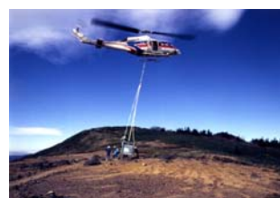
写真-2 ヘリコプター（「あおぞら」）での運搬・設置
