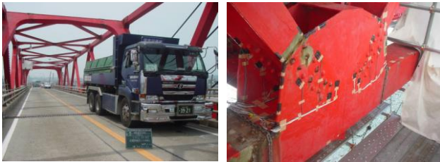
図-14 撤去前のトラス橋における荷重試験状況
