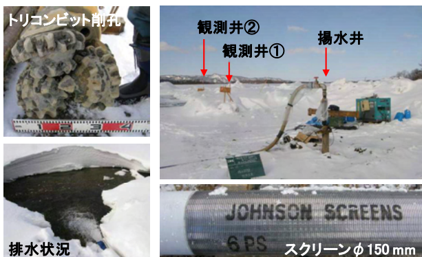
図-6 揚水試験状況
