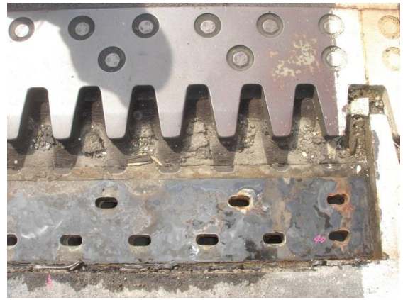
写真-4 フェースプレート撤去状況
