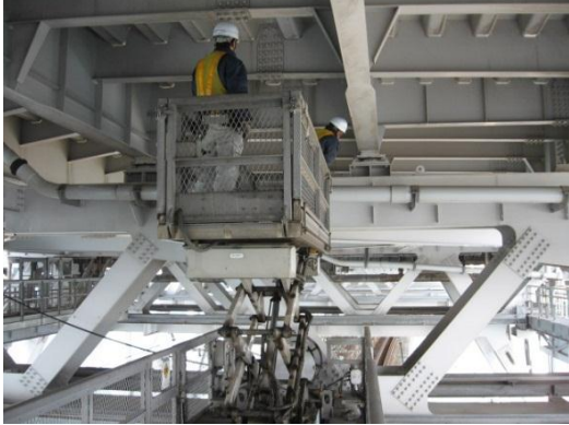
写真-2 補剛桁内面作業車からの目視点検状況
