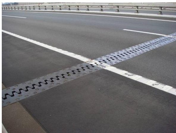
写真-1 鋼床版伸縮装置全景
