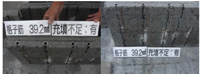
写真—7 断面積 39.2mm 2 格子筋の放熱管周囲の充填性状況
