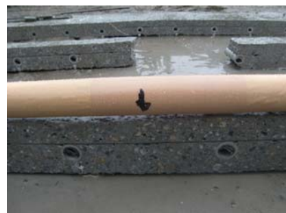
写真-4 断面積 6.6 mm 2 格子筋下の空隙状況
