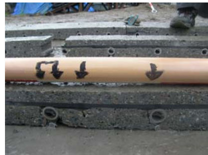
写真-3 断面積 39.2 mm 2 格子筋下の空隙状況
