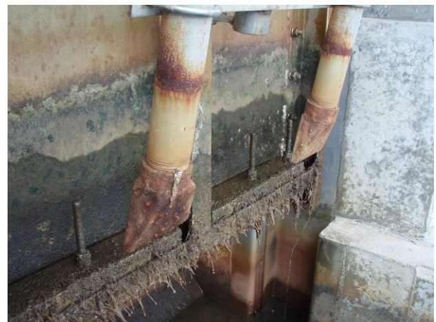
図11. 運用5か月後のノズルの状況
