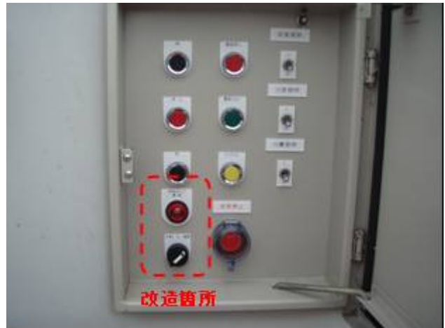
図10. 樋門操作盤にスイッチを増設した例
