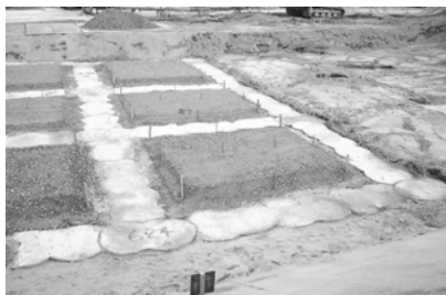
図-1 格子状固化処理工法の施工事例
